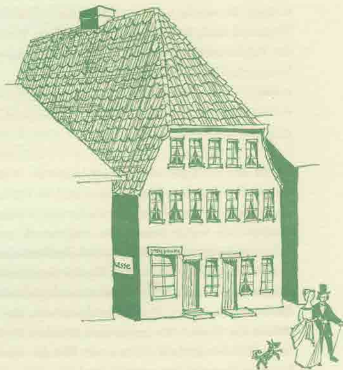
Vom Jahre 1884 an war das Haus des Rechnungsführers Heinrich Seiffert Sitz der Sparkasse. Das Haus brannte 1886 ab. Jetzt befindet sich an dieser Stelle das Haus der Firma Ludwig Hanff, Großflecken 52/54
